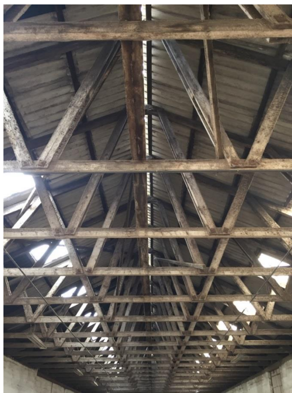
Tagkonstruktion indefra (Anja Heinsen)
